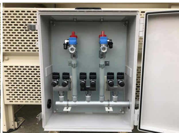
・災害時ガス器具ガス取り出し口(内部)
