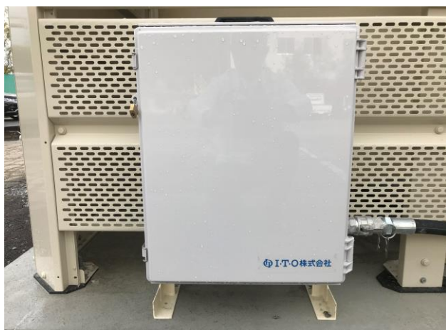
・災害時ガス器具ガス取り出し口(外観)
