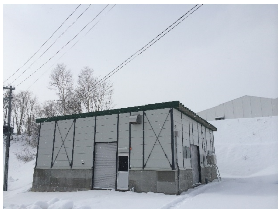
浸出水処理施設
